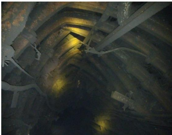
Hình PL 2.4. Hiện tượng biến dạng, lún tại đường lò thượng vận tải 14.5
